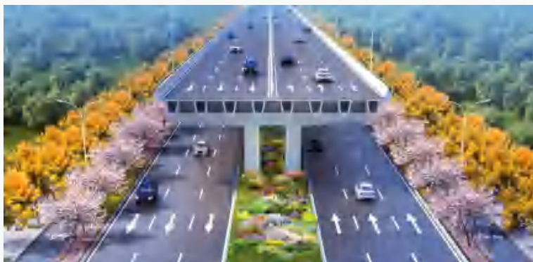
郑州市农业路（西四环-西三环）快速化工程施工
